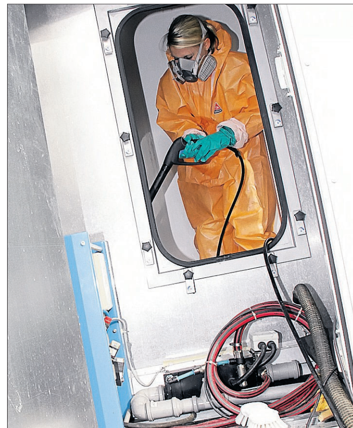
Mit einer Profi-Schutzausrüstung spritze ich das Innere der Klimaanlage aus.
